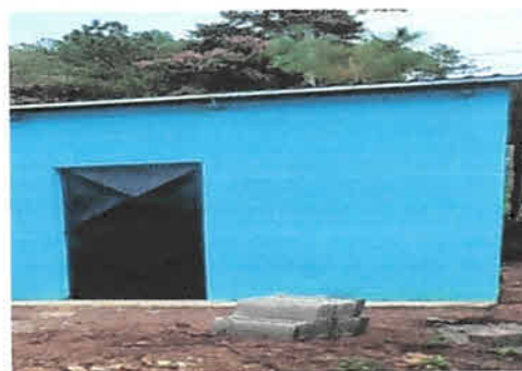
Foto 6: sustitución de puerta de cocina
