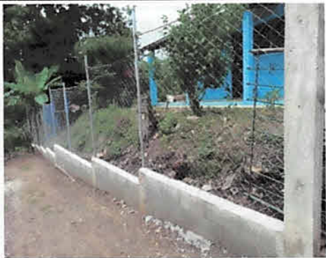
Foto 1: Reconstrucción de muro perimetral e instalación de malla
