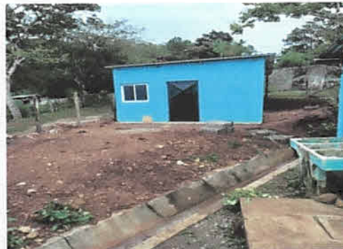
Foto 2: Remozamiento de cocina, sustitución de estufa, incluyendo chimenea y 1 plancha de metal
