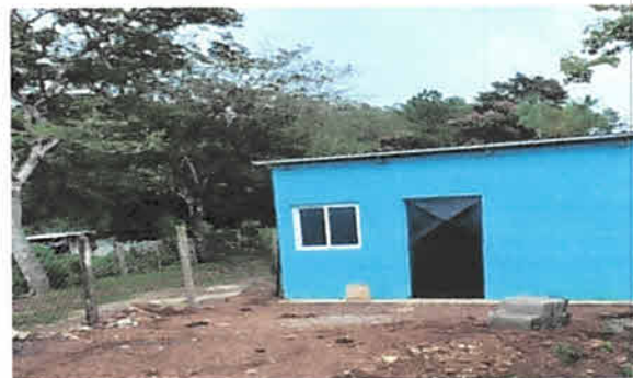
Foto 4: Mejoramiento perimetral de cocina con apoyo de estructura de concreto y metálica incluyendo elementos principales
