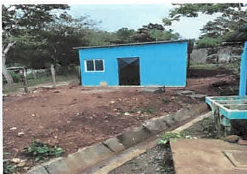
Foto 3: Sustitución de techo, lámina del módulo de cocina por lámina calibre 26 y sustitución de estructura metálica para techo de módulo de cocina costanera de metal galvanizado calibre 16
